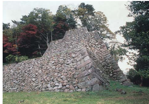
写真7 現在の辰巳櫓下 明治40年に改変を受けたが、小角上部はかろうじて文化の修築跡を残す。
