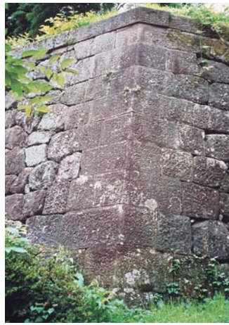
写真2 御乳母之池下石垣の出角 (文化4年)「周囲ハツリ」残し、小面は粗く仕上げる。
