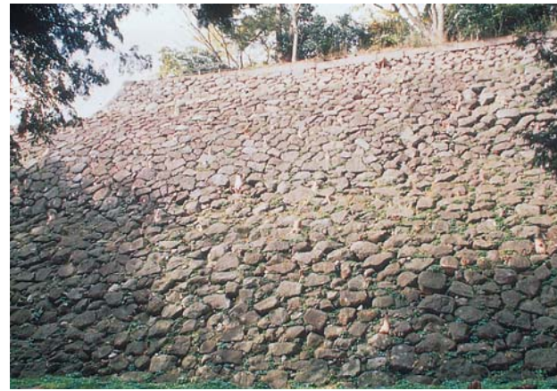
写真6 辰巳櫓下東側 文化13年の修築の跡（下段上半）が明瞭に観察できる。
