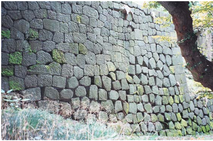
写真8 御居間先土蔵下石垣 上半部は文化5年積直し、下半部はパネル状間詰石が抜け落ちる。
