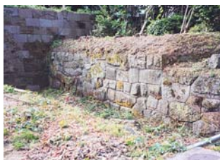
写真19 切手門左脇石垣 金場 取残積 左奥は布築切 合積
