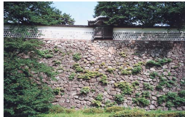
写真5 石川櫓下には数字刻印の「寛文石」が散在、加工石主体だが目地を崩し粗く積む「野面積」
