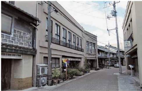
写真7 岡山市五福通りの看板建築と伝統的建造物 (筆者撮影)
