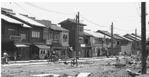
写真4 千本今出川・西入ル付近道路拡張工事(昭和初期頃) 梅寿堂: http://www.baijudo.com/c686.htm
