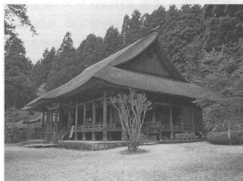
[写真2] 慈恩寺本堂
