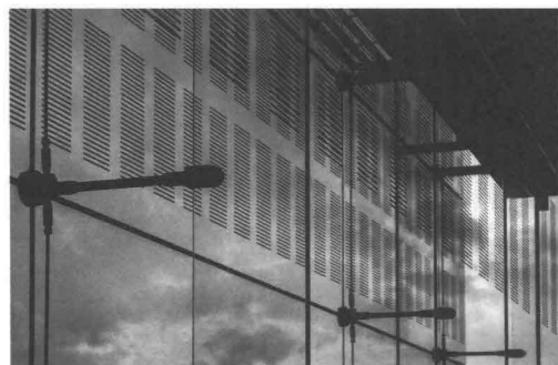
[写真4] 7階の南面ダブルスキン構造の窓面
