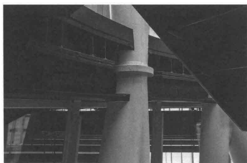
[写真3] 5番チューブ内の床と天井部分のプレート ©Izuru ECHIGOYA
