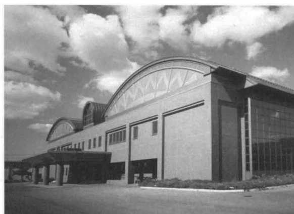
図3 山形県産業創造支援センター(同HPより)
